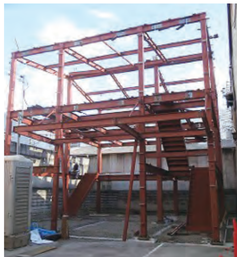
鉄骨建方完了
