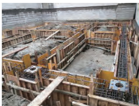
基礎型枠状況
