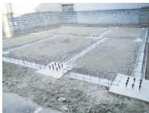
埋戻完了建方前状況
